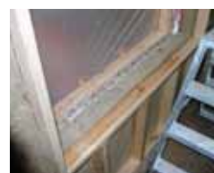
Figuur 8: Foto's van de bouw van de woning in Heusden Destelbergen
