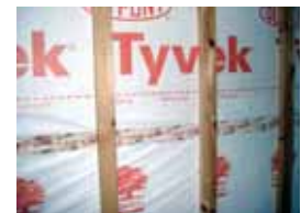
Figuur 29: Voorbeelden van zelfklevende voegdichtingsband vastgedrukt door middel van een lat.
