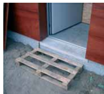
Figuur 31: De deuren hebben, net als de ramen, een volledig rondomlopend kader; het onderprofiel is wel beperkt in hoogte.
