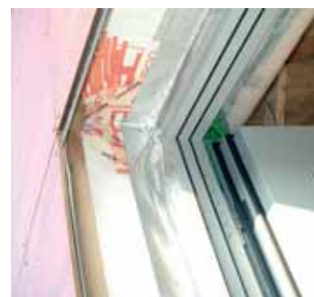
Figuur 30: Illustraties luchtdichting bij kozijnen.
